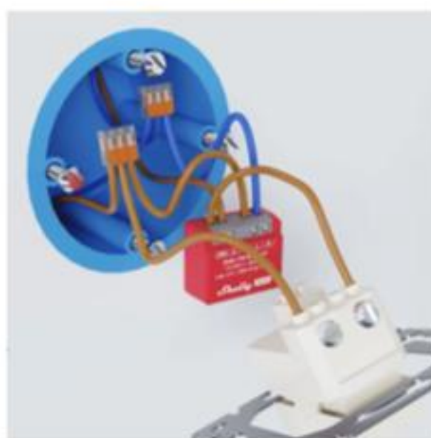
⑤将火线接入开关 控制线接入SW端
