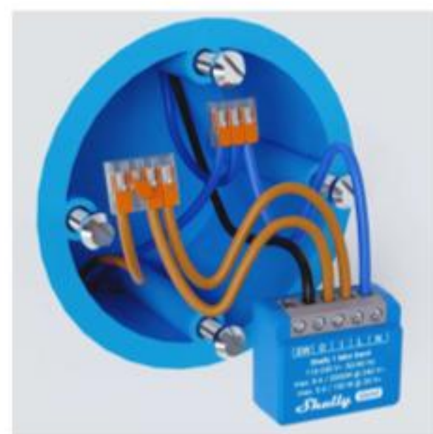
④将火线接入设备L端 和I端
