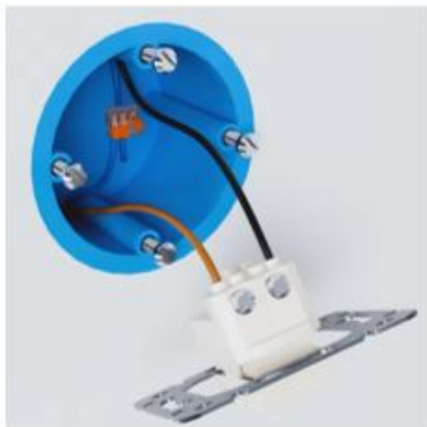
②取下开关面板 确认线序
